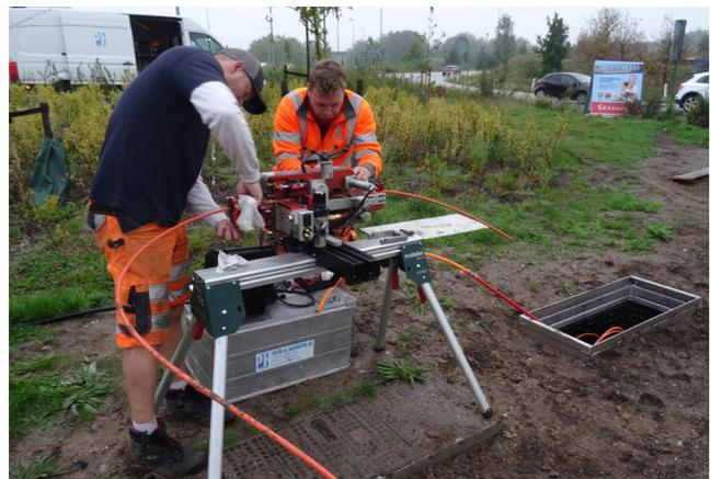
*Petri & Haugsted A/S beim Einblasen eines Faserkabels von 2.800 Meter Länge in Verbindung mit der Etablierung der Stadtbahn in Kopenhagen. Kristopher Viklund (links) und Nicolai Granum sind dabei ein Jetting MJet V3 Einblaswerkzeug für die Einführung des Kabels aufzubauen.*
