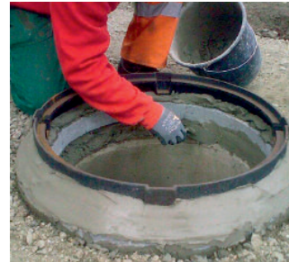
Schachtabdeckungen lassen sich zeitsparend mit PCI Polyfix plus setzen.
