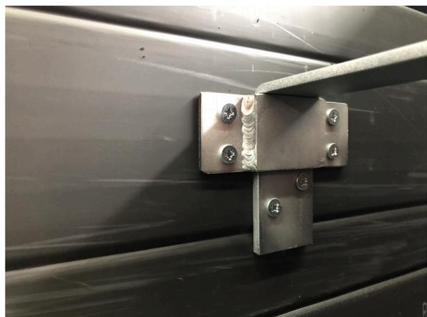
zus. verschraubte Muffenablage (2 Spax) -
